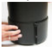
Kruvige kokku aga ainult niipalju, et liitmikukatet saab veel üles-alla liigutada
